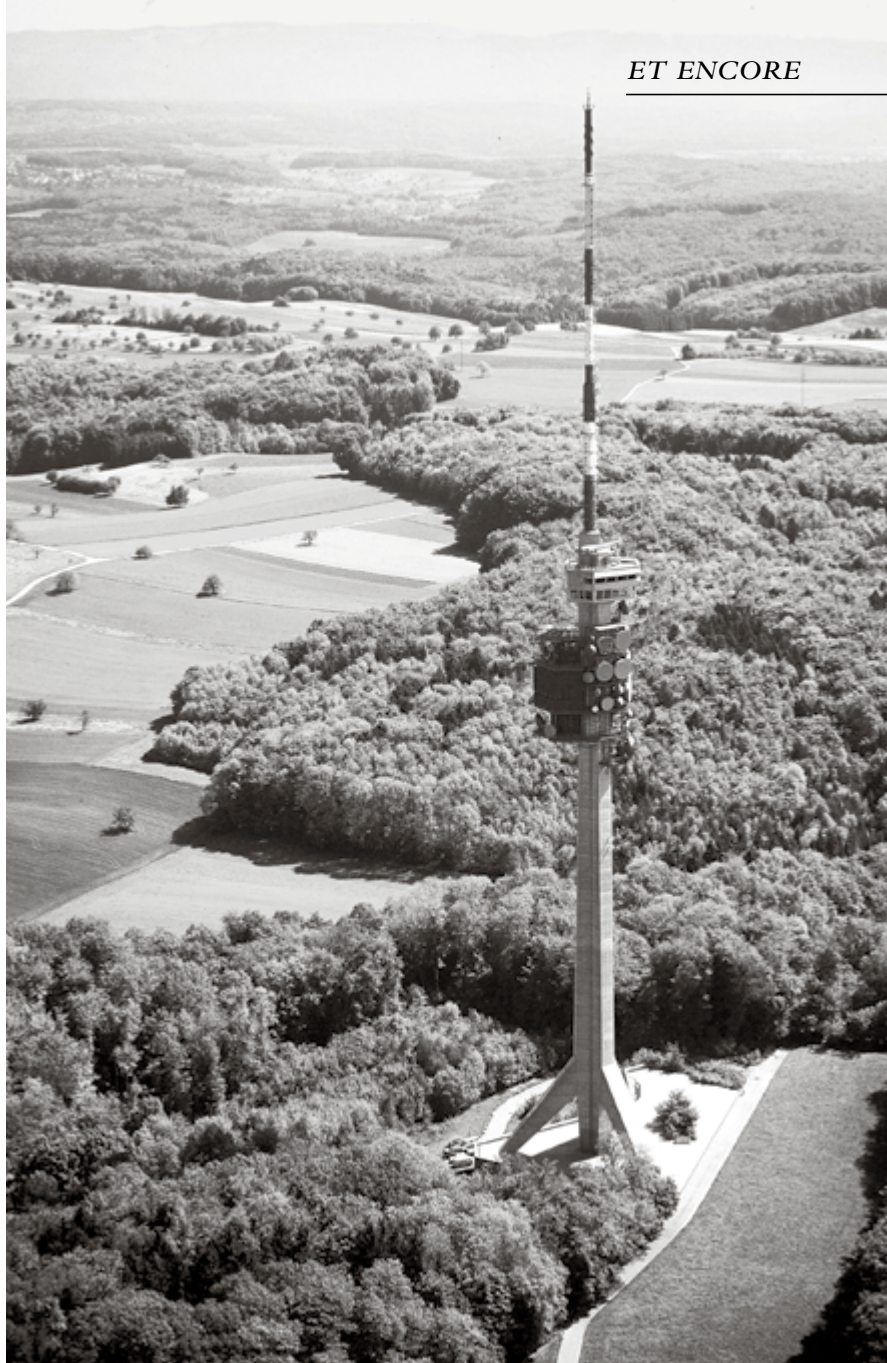
La tour de télévision de Saint-Christhona, mise en service en 1984
